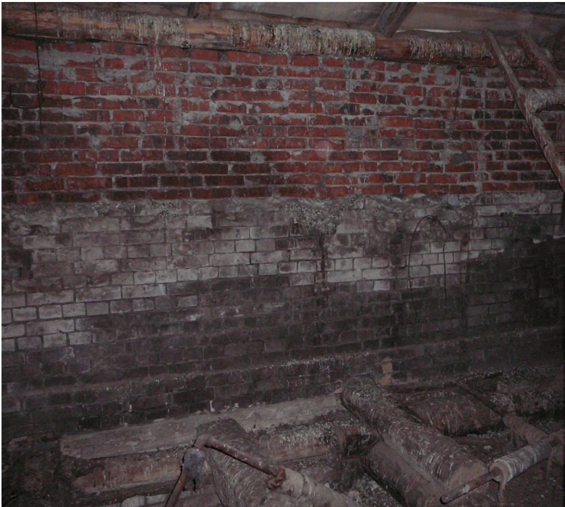
Фотофиксация чердака. Следы примыкания исторической кровли. Сливные отверстия. Современные закладки парапетов. Историческая штукатурка на стене башни.
